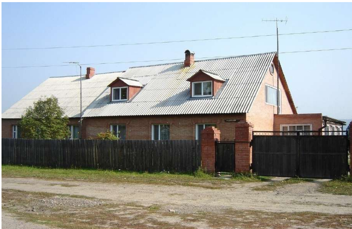
Фото 2. Двухквартирные жилые дома по ул. Центральной (с. Юкеево).
