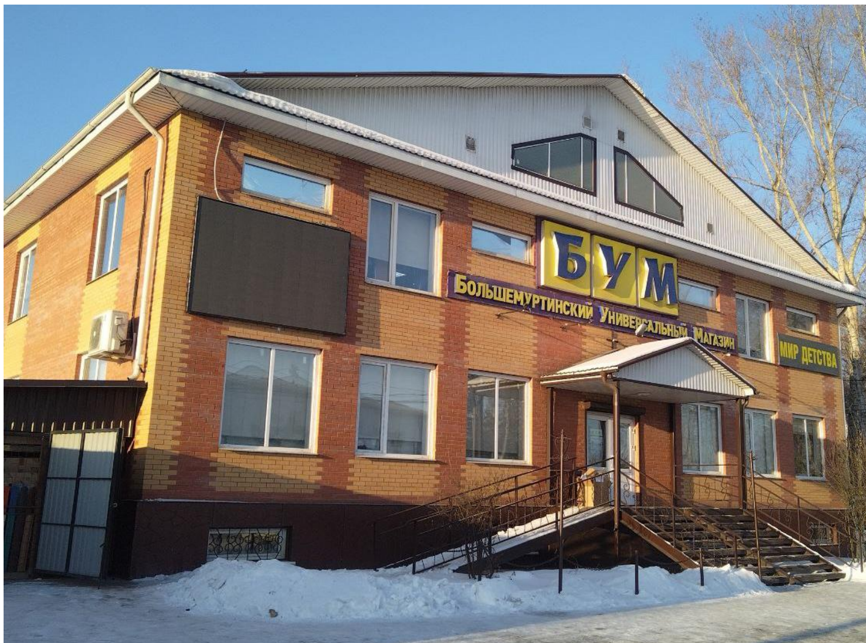
Схема размещения рекламного видеозэрана № 1/Э (2800x2240) на фасаде нежилого здания «Большемуртинский универсальный магазин» по адресу: пгт. Большая Мурта, ул. Сверлова, 103
