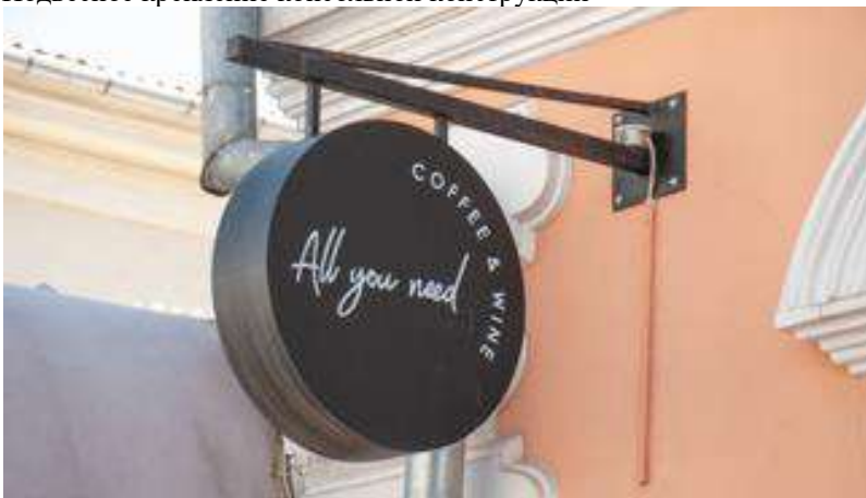
Подвесное крепление консольной конструкции
